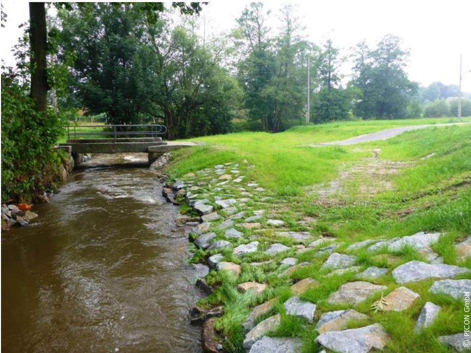
Instandgesetztes Brückenbauwerk und neu hergestellte Umflutrinne
