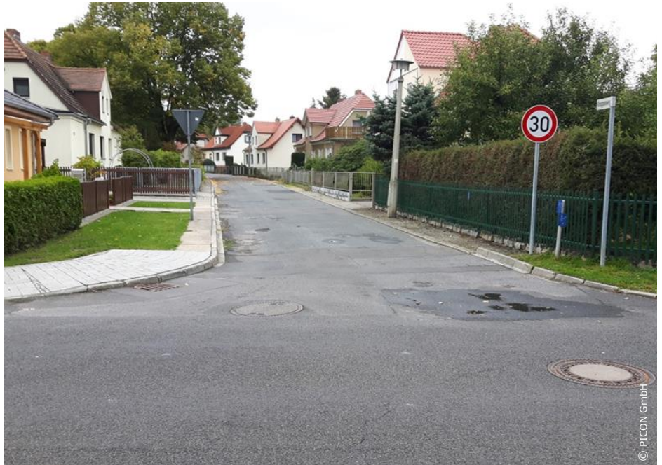
Knappenweg in Weißwasser, Ausgangszustand
