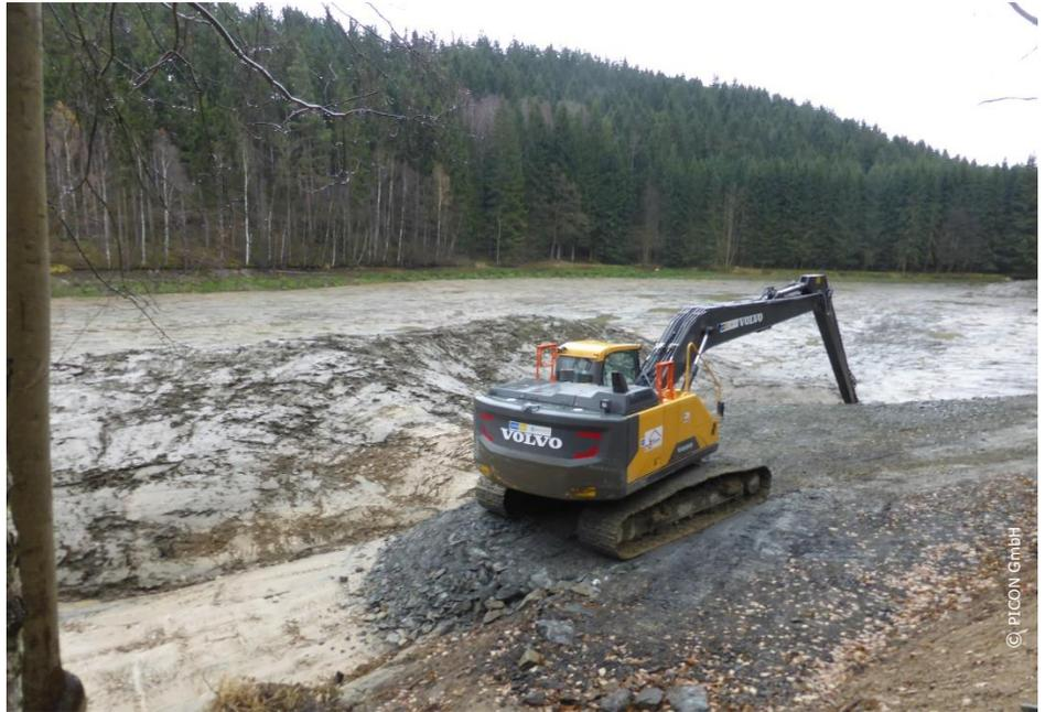
Langarmbagger bei der Beräumung der Vorsperre Ramoldsreuth
