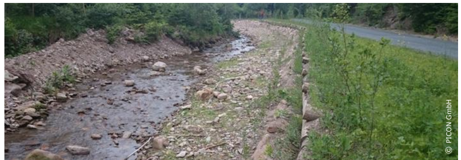
oben: gesicherte Uferabbrüche an der Talsperre Bautzen nach Instandsetzung unten: Forstweg mit Böschung nach Fertigstellung
