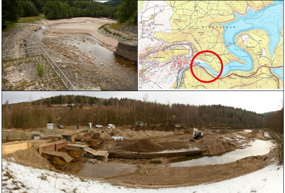
Vorsperre Schönheiderhammer der Talsperre Eibenstock
