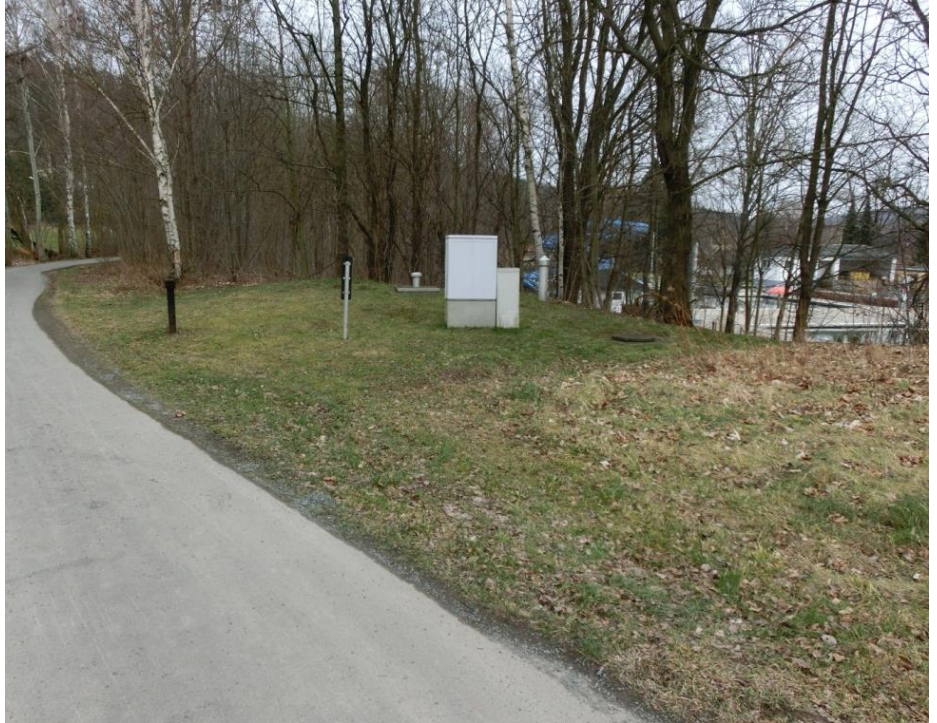
Rohrleitungsabschnitt am Abgabeschacht Bad in Berggießhübel
