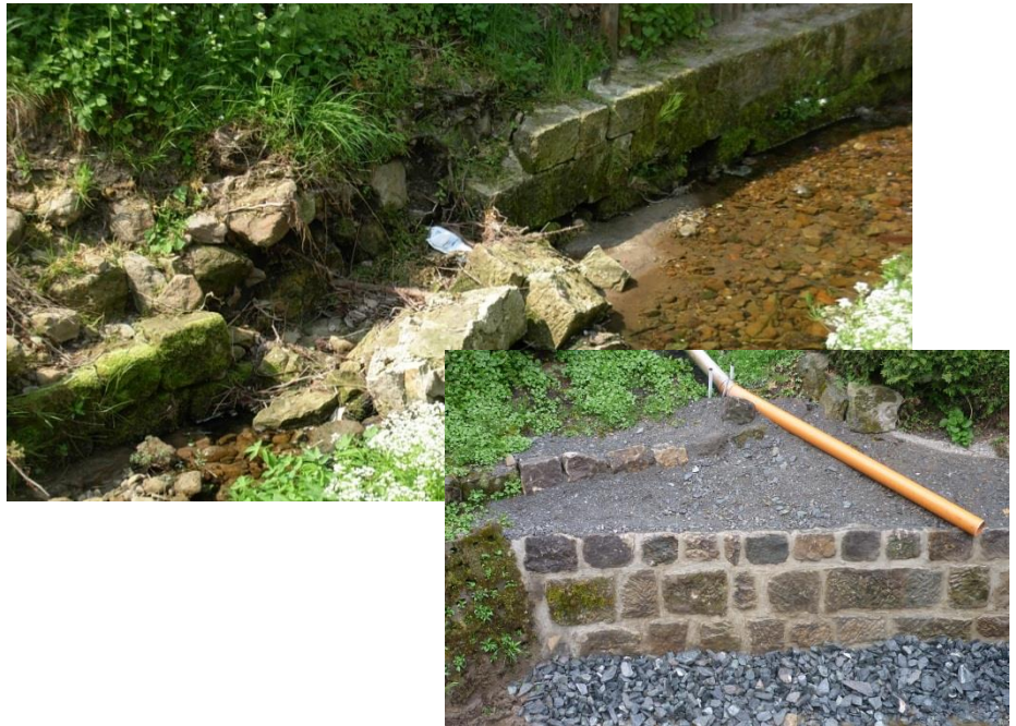
Langenhennersdorfer Dorfbach vor und nach der Instandsetzung
