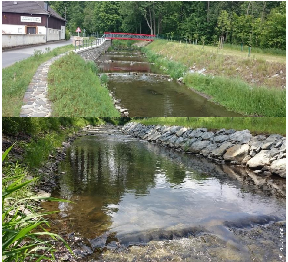
Sohlgleiten in Riegel-Becken-Struktur
