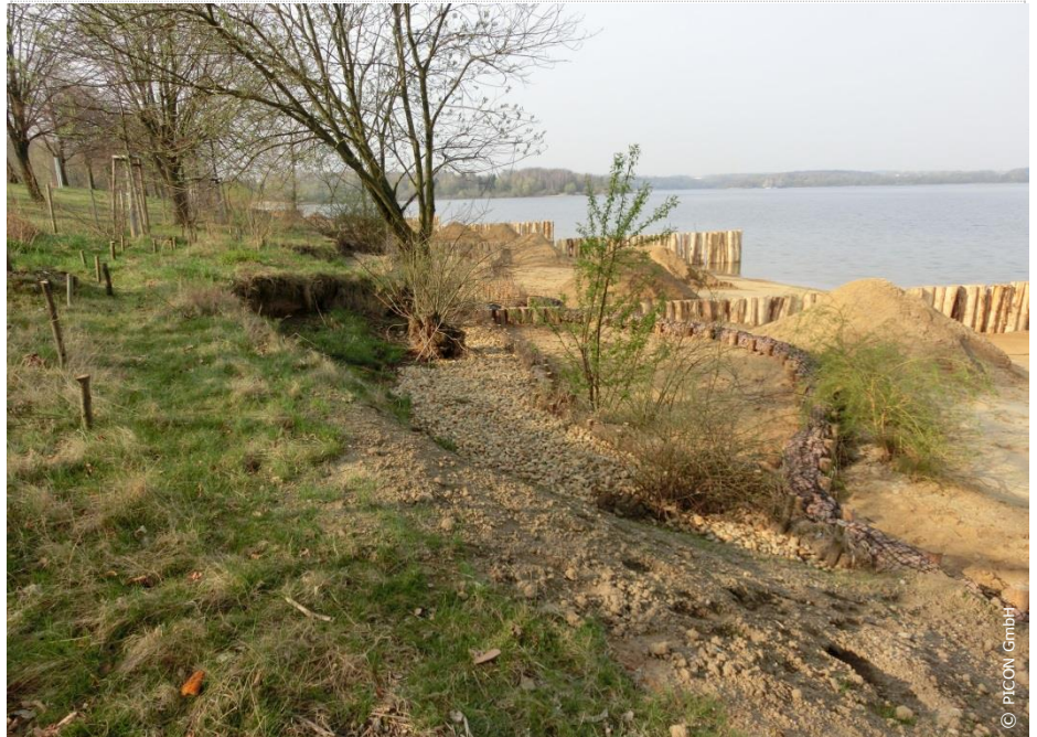
gesicherte Uferabbrüche an der Talsperre Bautzen nach Instandsetzung
