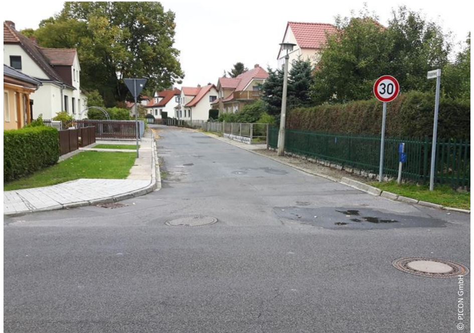
Knappenweg in Weißwasser, Ausgangszustand
