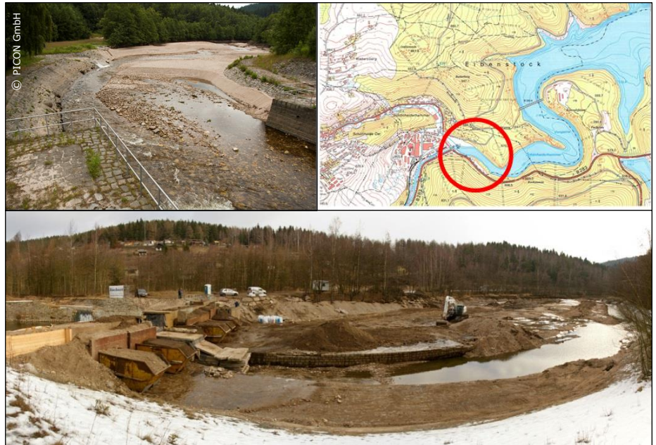
Vorsperre Schönheiderhammer der Talsperre Eibenstock
